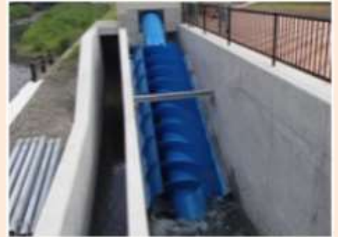
小鷹水力発電所 (薩摩川内市)
