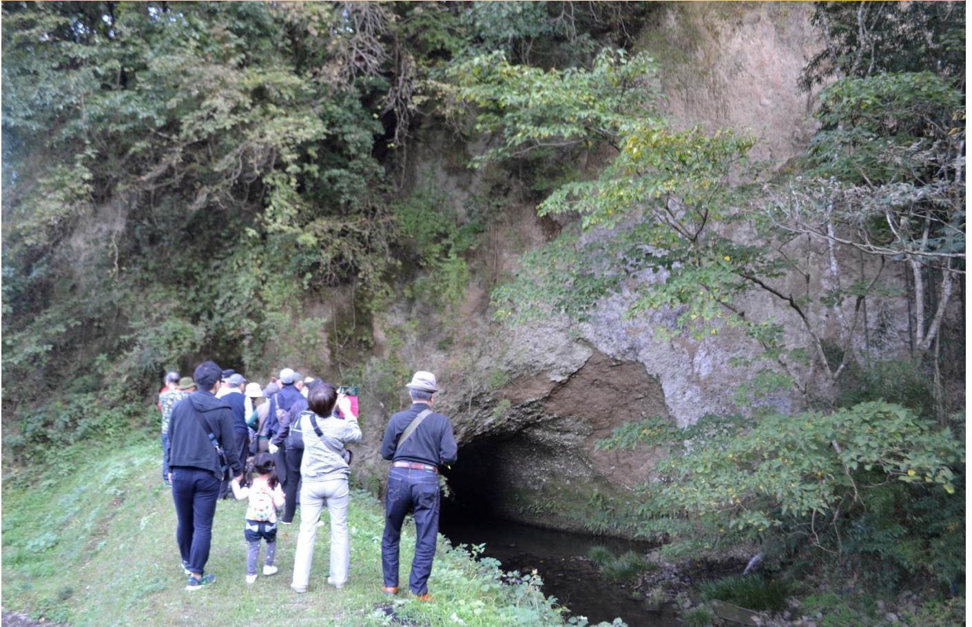
▲「ぬき」と呼ばれるシラス地形につくられた用水路のトンネル。
